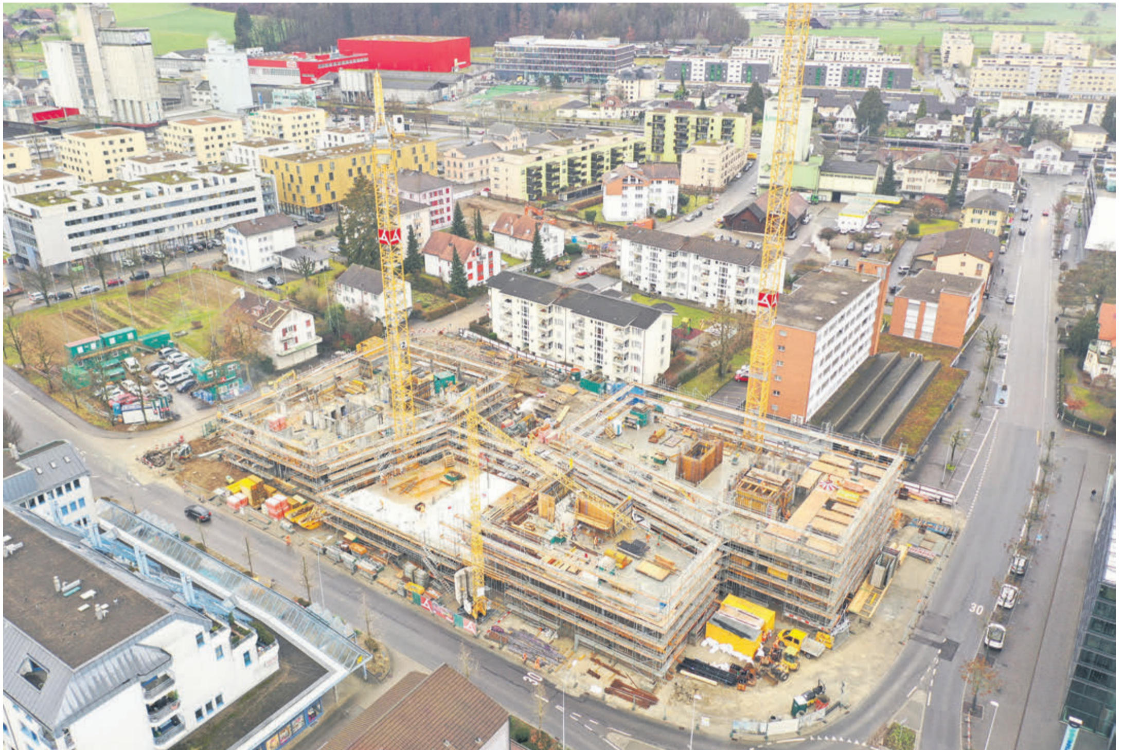
So präsentierte sich die «Dreiklang»-Baustelle in Sursee Anfang Februar aus der Vogelperspektive. Rechts, in der Ecke Bahnhof-/Chr.-Schnyder-Strasse, entsteht das höhere der beiden Hochhäuser mit dem neuen Regionalsitz der Lukb, links, in der Ecke Chr.-Schnyder-Strasse/Schnydermatt, das andere Hochhaus und dazwischen der niedrigere Gewerbebau. FOTO CLAUDIO D'AMATO, BAULEITER ANLIKER AG GENERALUNTERNEHMUNG
